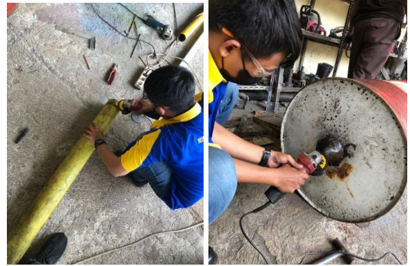
Gambar 3. Pemotongan Pipa dan pelubangan pada drum
